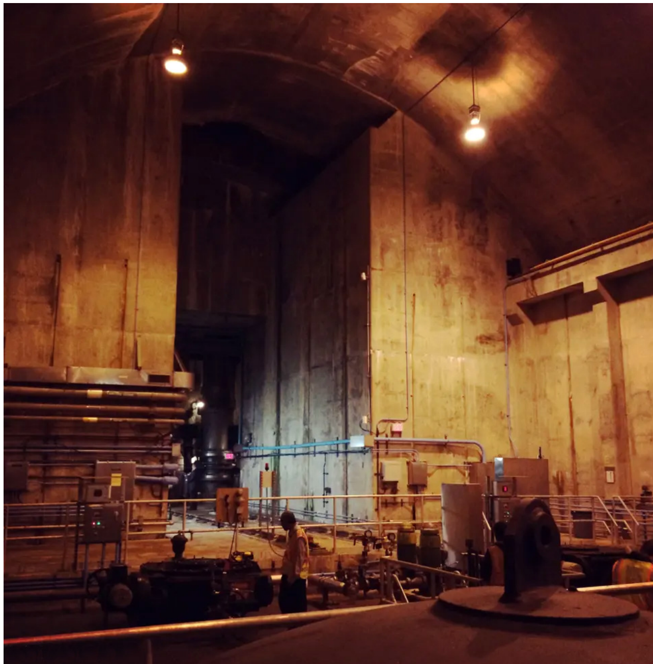
Градски водоводен тунел бр.3 Централ парк, Менхетн 2013
