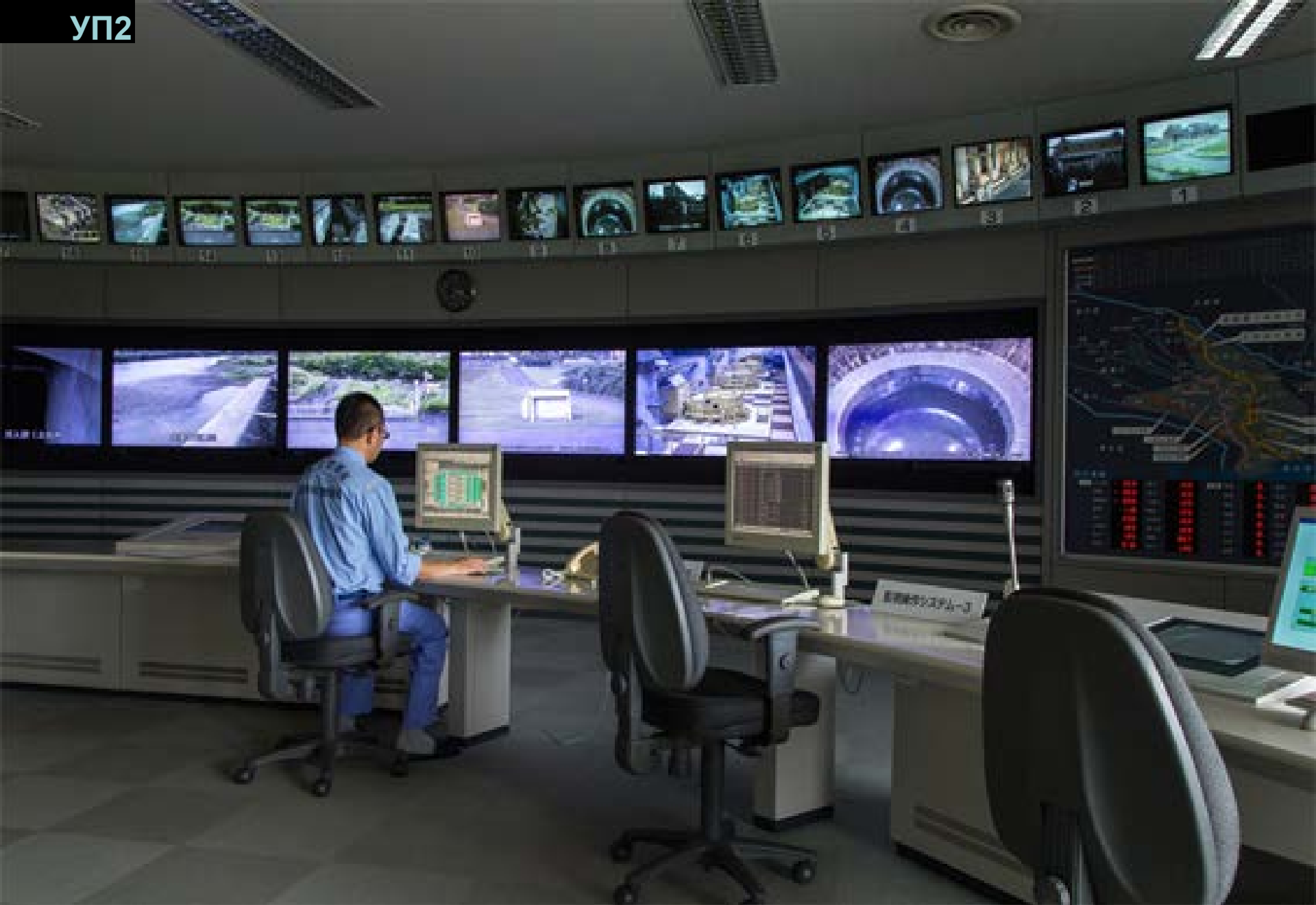
Контрола на подземниот систем на тунели за заштита од поплави (MAOUDC), Токио 2006
