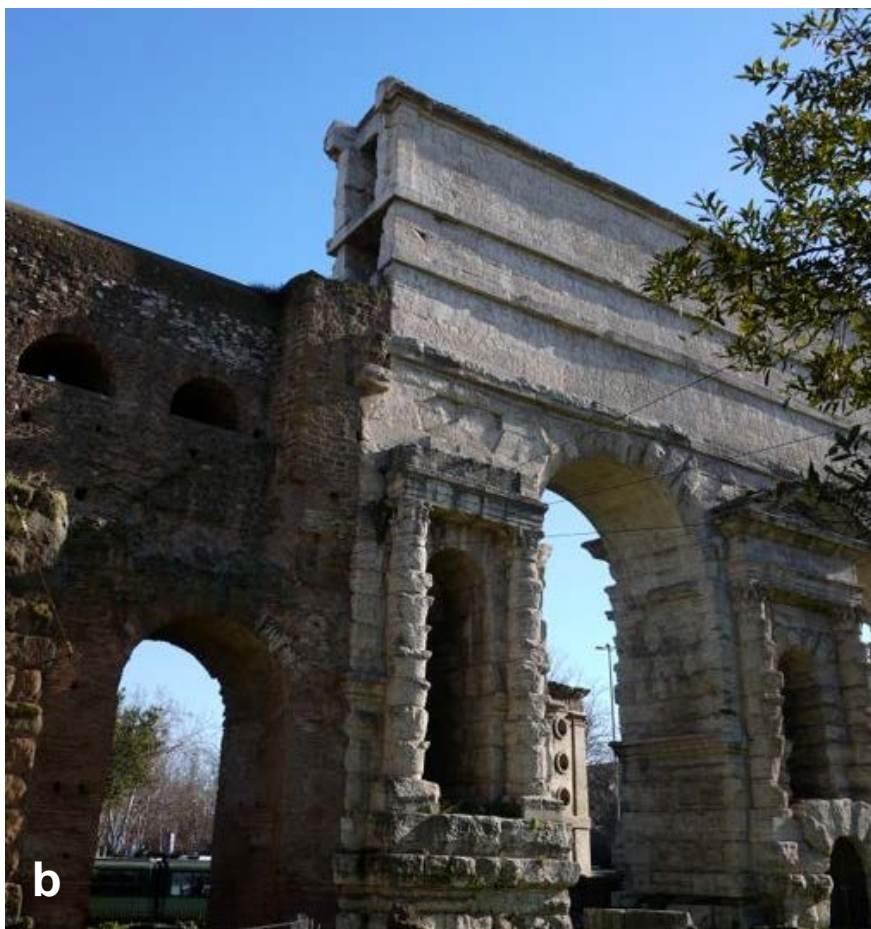
(a) Аквадуктот Aqua Anio Novus, изграден сса 50 год. н.е. (b) Porta Maggiore како дел од Аквадуктот со приказ на доводните канали
