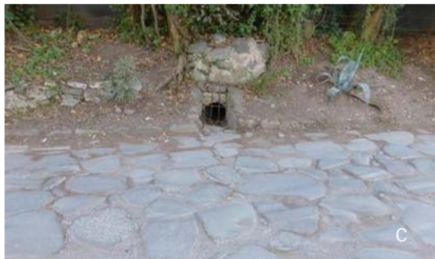
(a) карактеристична конструкција на римските патишта; (a') изградба на патиштата (b) состојба на патиштата денес; (c) систем за одведување на атмосферската вода од патот
