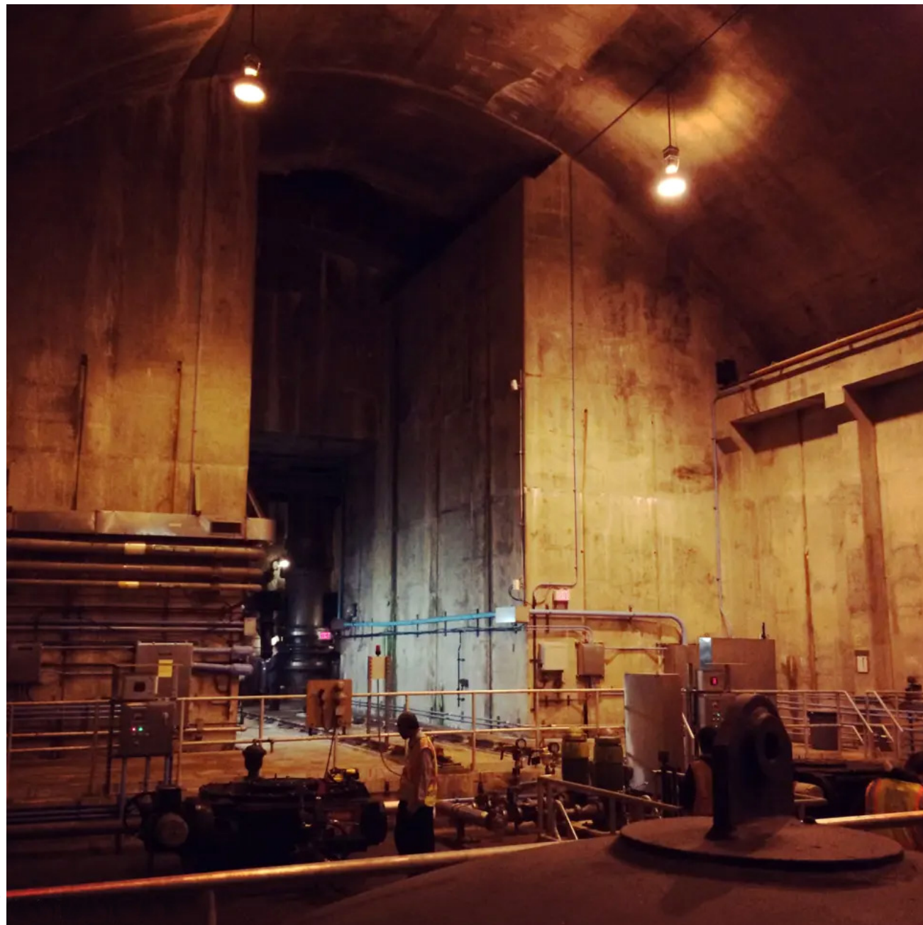
Градски водоводен тунел бр.3 Централ парк, Менхетн 2013
