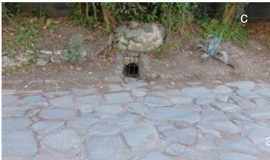
(b) карактеристична конструкција на римските патишта; (c) систем за одведување на атмосферската вода од патот
