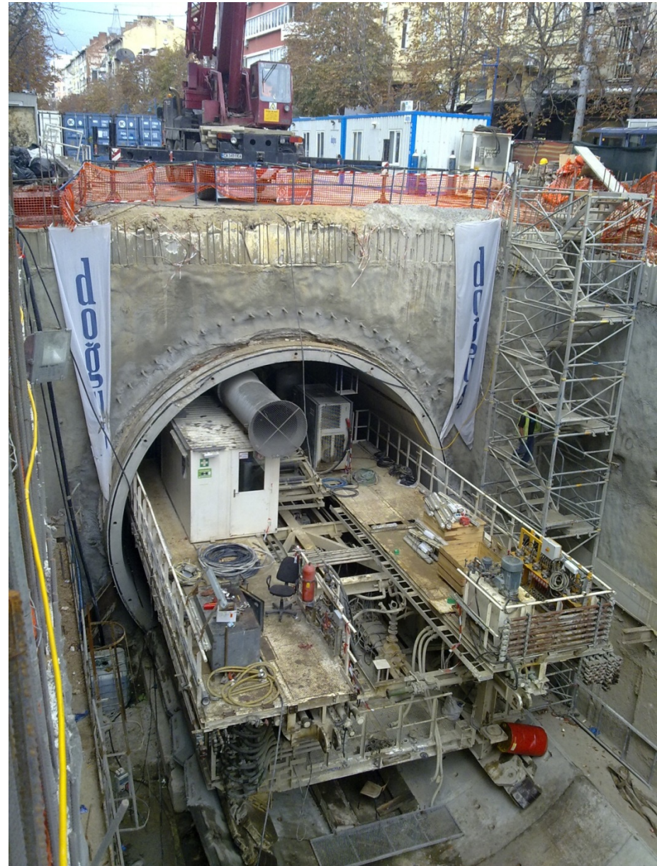
Пробивање на трасата на линија на метро
