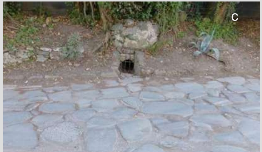
Сл. 1 (а) Via Appia, изградена ссa 300 п.н.е. која ги поврзувала Рим и Бриндизи; (b) карактеристична конструкција на римските петишта; (c) систем за одведување на атмосферската вода од патот
