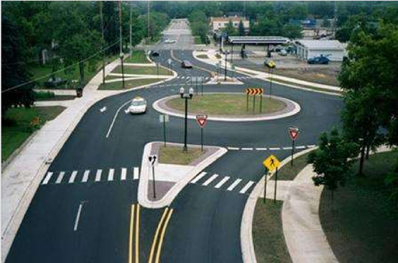
Сл. 6 Приказ на мерки за смирување на сообраќајот на „Т“ крстосница на две улици со повеќе коловозни ленти, со користење на кружен успорувач како и со менување на трасата на постојната сообраќајница пред пристапот до крстосницата со цел за намалување на брзината
