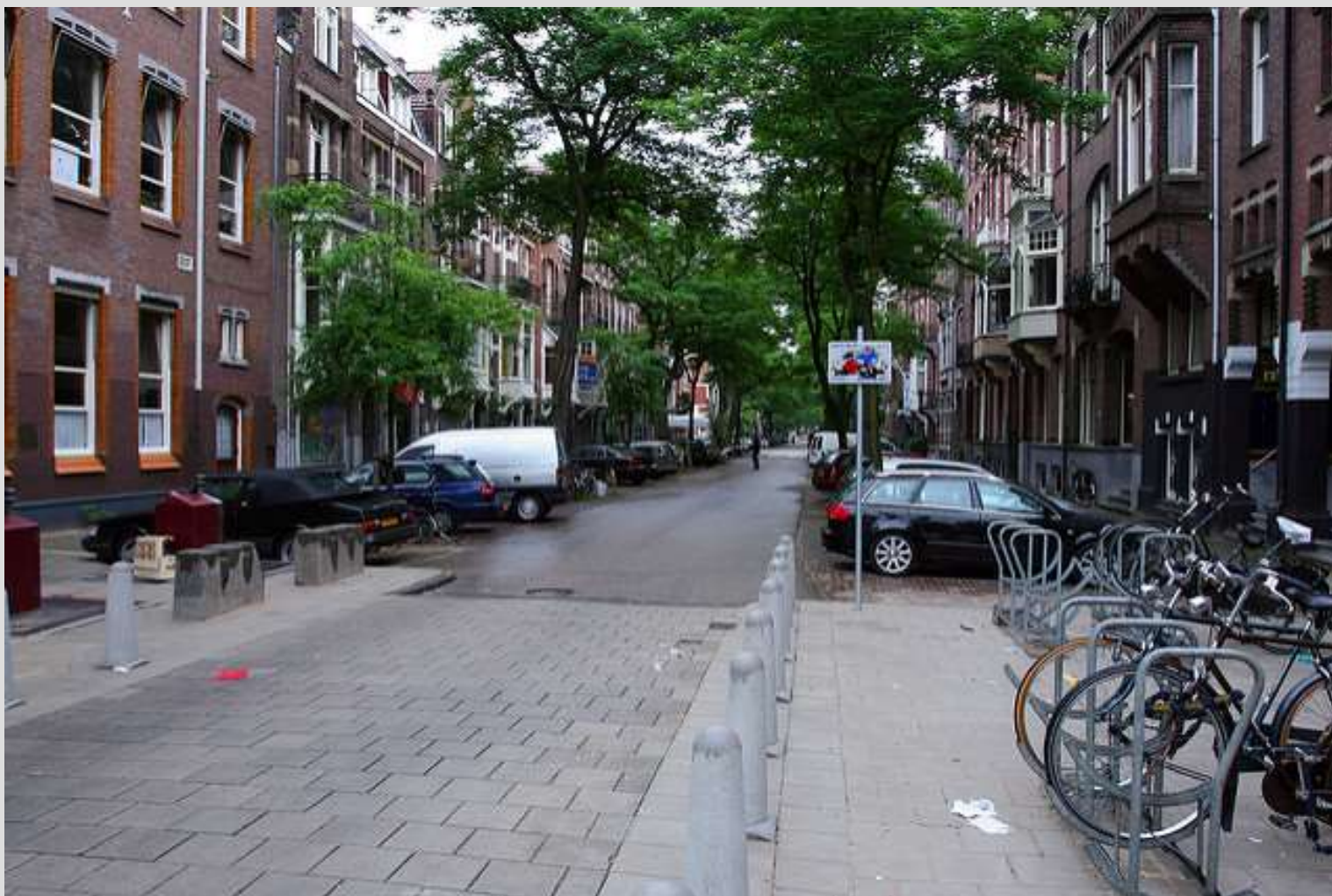
Сл. 7 Примена на повеќе мерки за смирување на сообраќајот во доминантно станбена зона, со примена на плато за успорување во ниво на тротоарот, намалување на бројот на ленти и нивната широчина, намалување на напречниот профил на сообраќајницата заради обезбедување на простор за паркирање на возила, моторцикли и велосипеди
