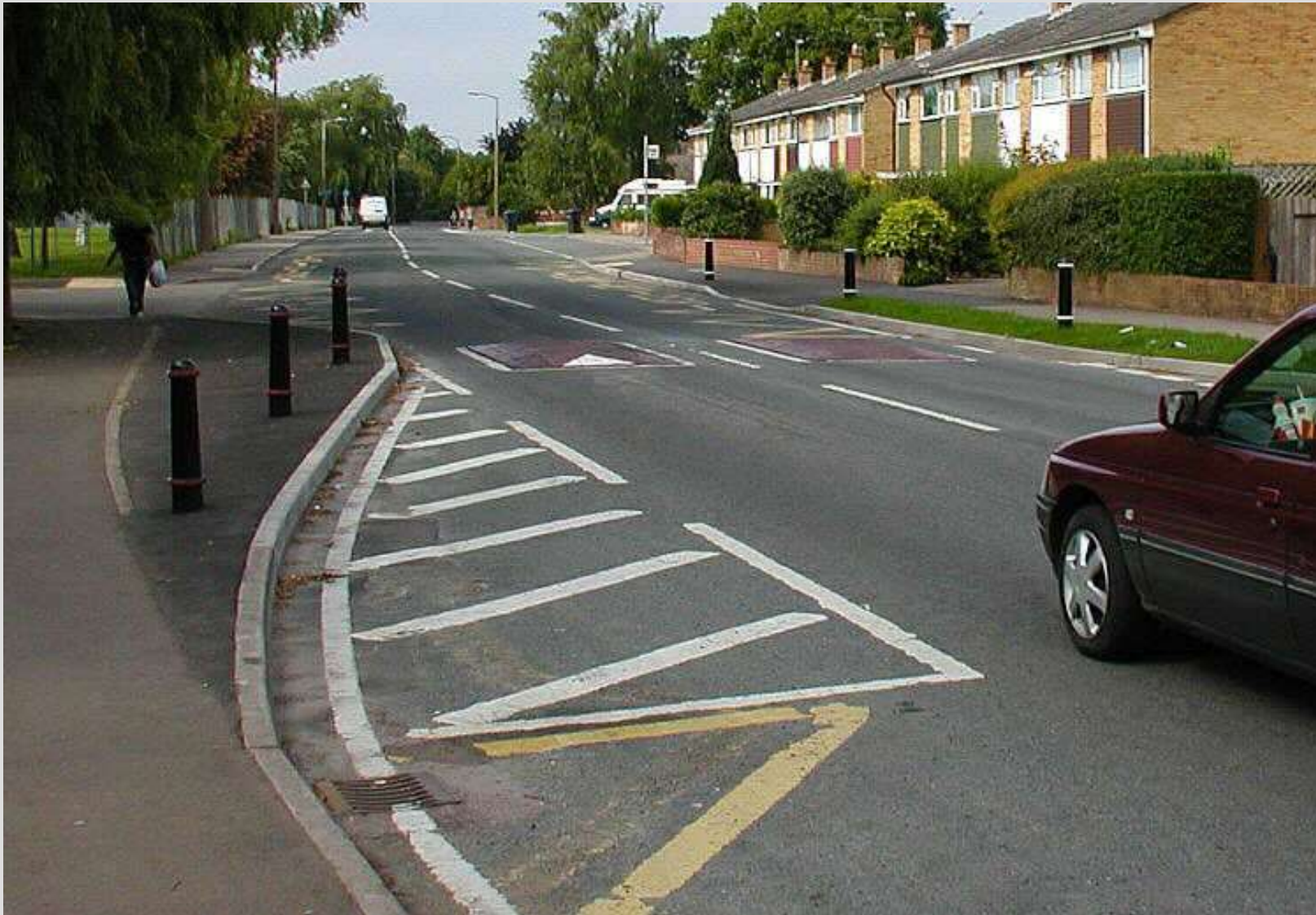
Сл.10 Успорувачи што овозможуваат намалување на брзината на индивидуалните патнички возила но не го попречуваат движењето на возила со поголемо меѓусовинско растојание на тркалата, како што се, на пример, противпожарните возила
