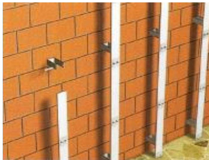
2. Поставување на носиви профили
