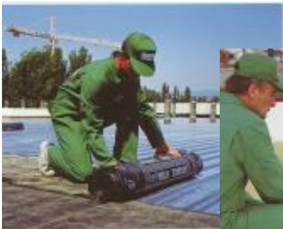
Поставување на парна брана
