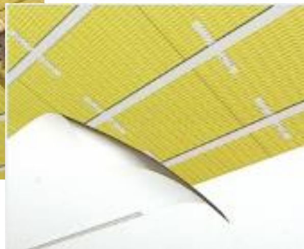
Поставување на парна брана
