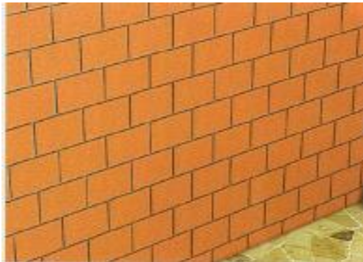
1. Сид подготвен за поставување на фасада
