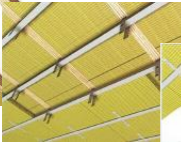
Поставување тервол плоча меѓу носач
