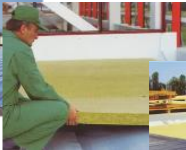
Поставување плоча тервол
