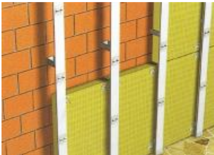
3. Поставување на тервол плоча
