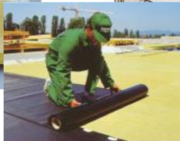
Поставување хидроизолација
