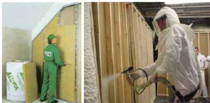
Сл. 39 Поставување на изолација на преградни сидови
