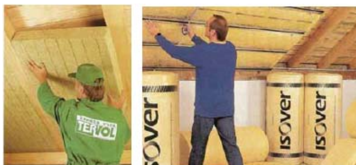
Сл. 28 Поставување на топлинска изолација на кос кров кај негреано поткровје: а) слоеви топлинска изолација; б) вградување
