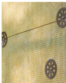
Сл. 33 Механичко прицврстување
