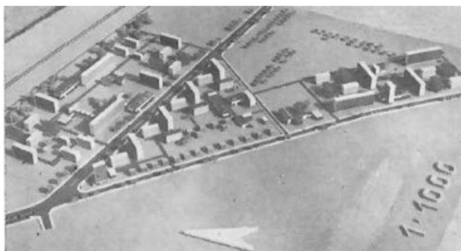
Слика 28. План и модел за реализација на населбата 11 Октомври, 1961, Ангелиќ. (Извор: ОУП (1964). Скопје планови-реализација. Книга 1)
