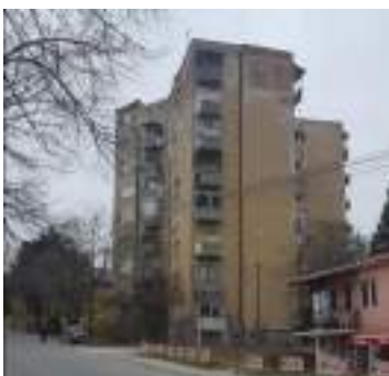
Слика 19. „Жаба зграда“, изглед
