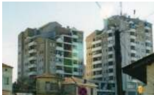
Слика 121. Комплекс „Гарнизон“ ( 17КУ0607 )
